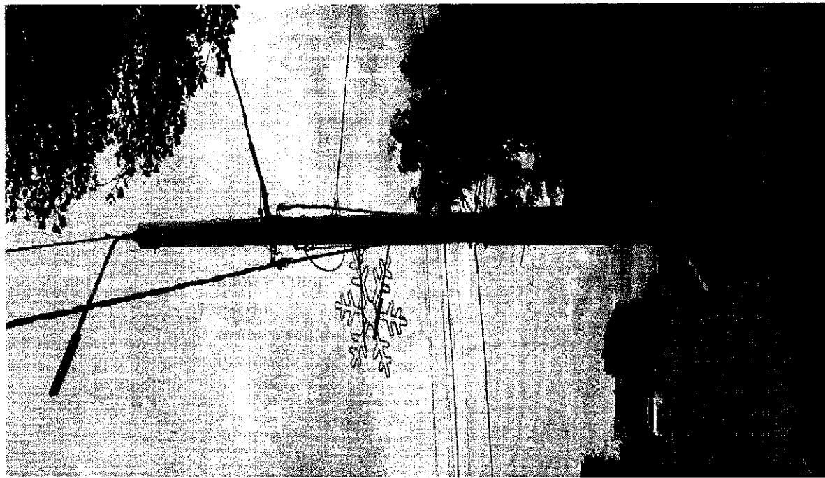
2.2. Однорожковый кронштейн со светодиодным светильником 219.
