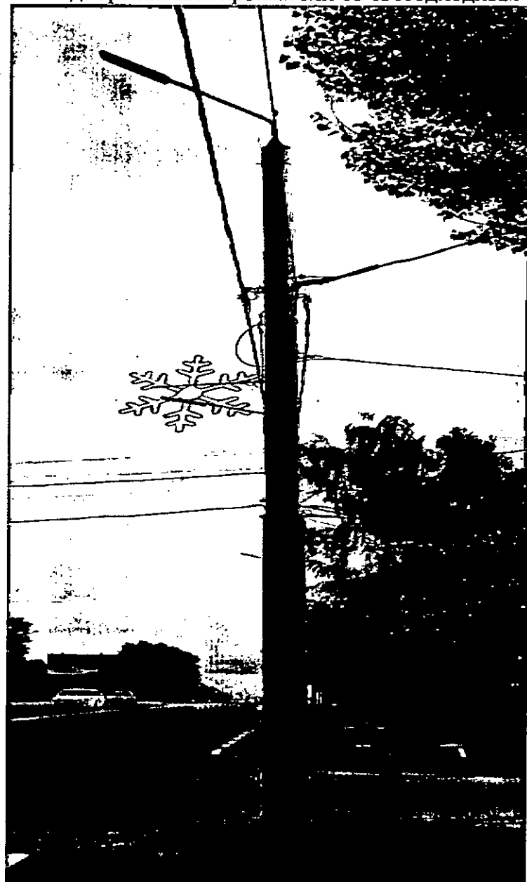
2.2. Однорожковый кронштейн со светодиодным светильником 219.
